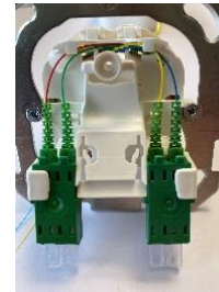
Lato superiore con 2 LC / APC (figura 4)
