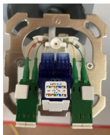
Piastra di adattamento montata (figura 13)
