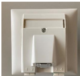
Scatola Hybrid senza OTO ID (figura 15)
