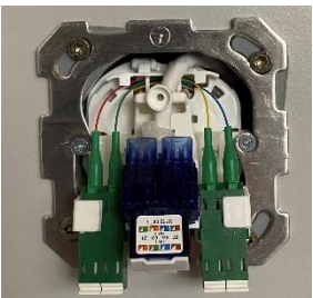
Scatola Hybrid senza coperchi (figura 14)
