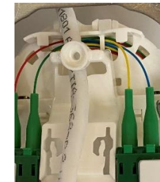
LAN Kabel einführen (Bild 9)
