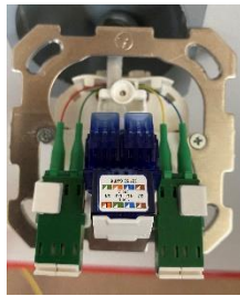
Adapterplatte montiert (Bild 13)
