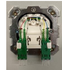
Adapterplatte montier (Bild 10)
